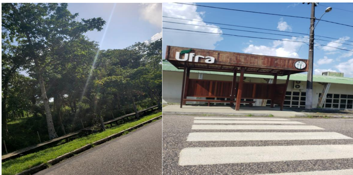
Figura 11 – Pontes e Paradas de ônibus dentro da UFRA
